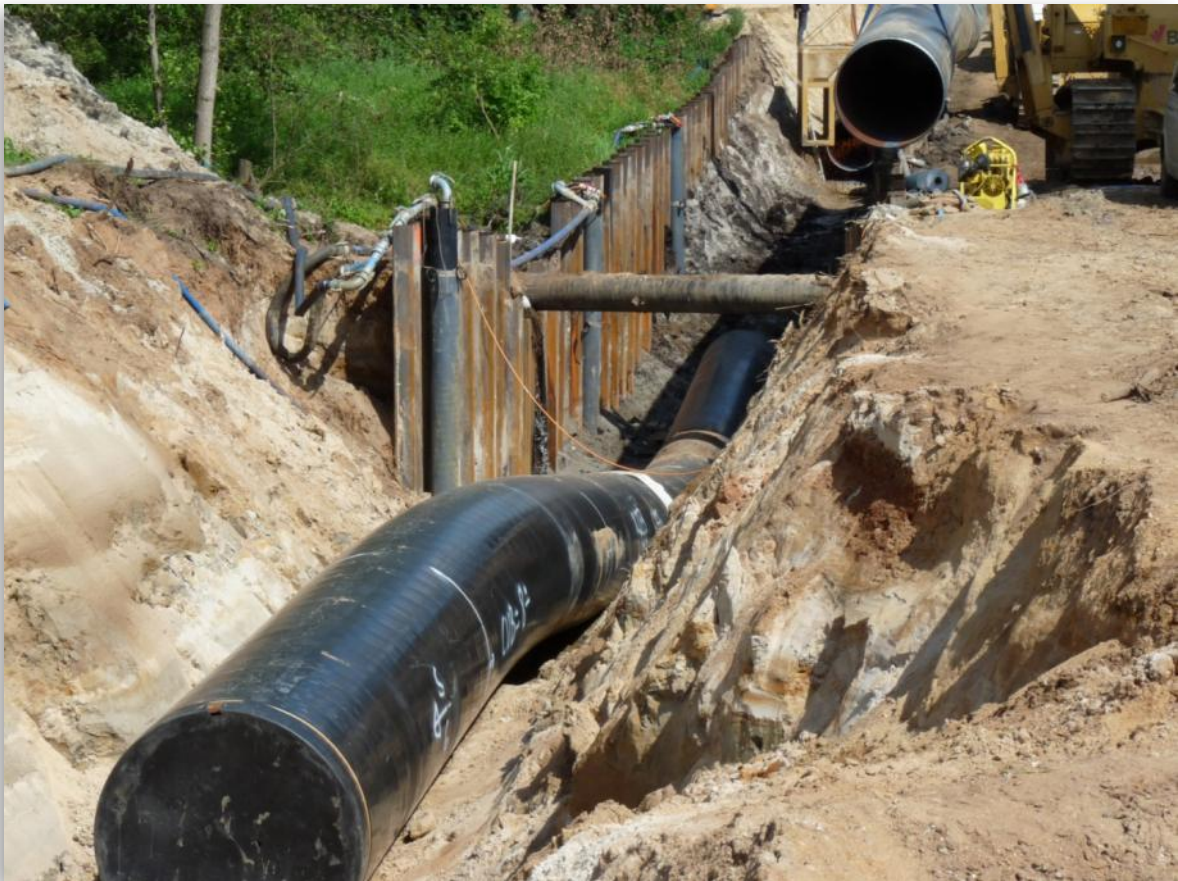
Erdgastrasse quert den Bach
